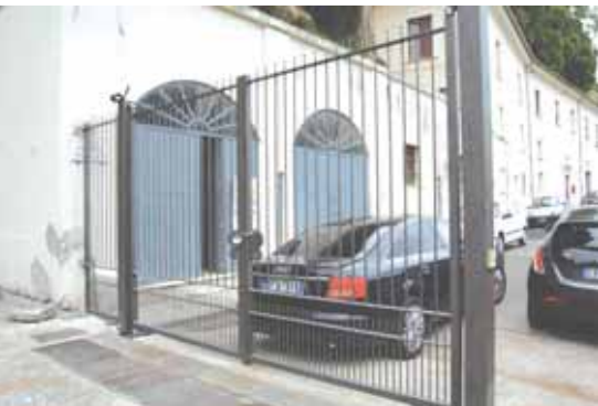
Il cancello della Badia visto dall'interno
